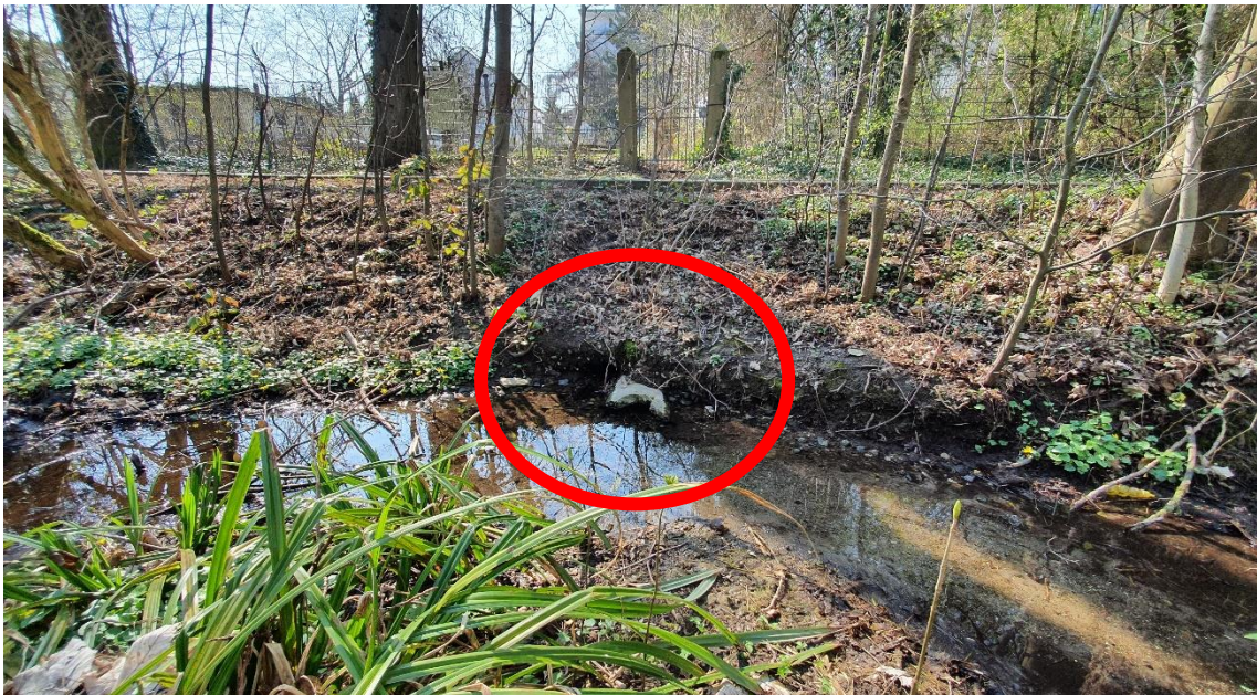
Abb. 0-2: vorhandener Grabenverlauf mit umzugestaltenden Steinzeug-/Betoneinleitungen (rote Umrandung, oben: Blick von Nordwest nach Südost, unten: Blick von Nordost nach Südwest)
